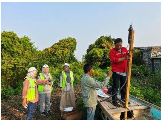
Gambar 5. Pemasangan Alat Penangkal Petir
