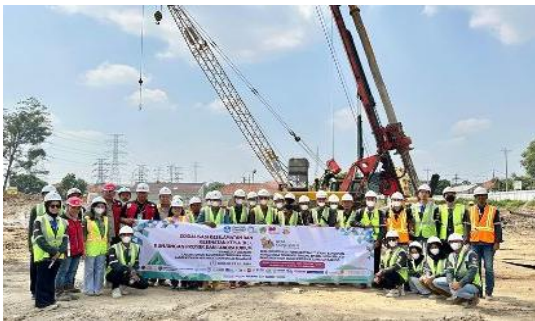
Gambar 2. Kunjungan ke Proyek Konstruksi Pondasi di Proyek PLN Ungaran
